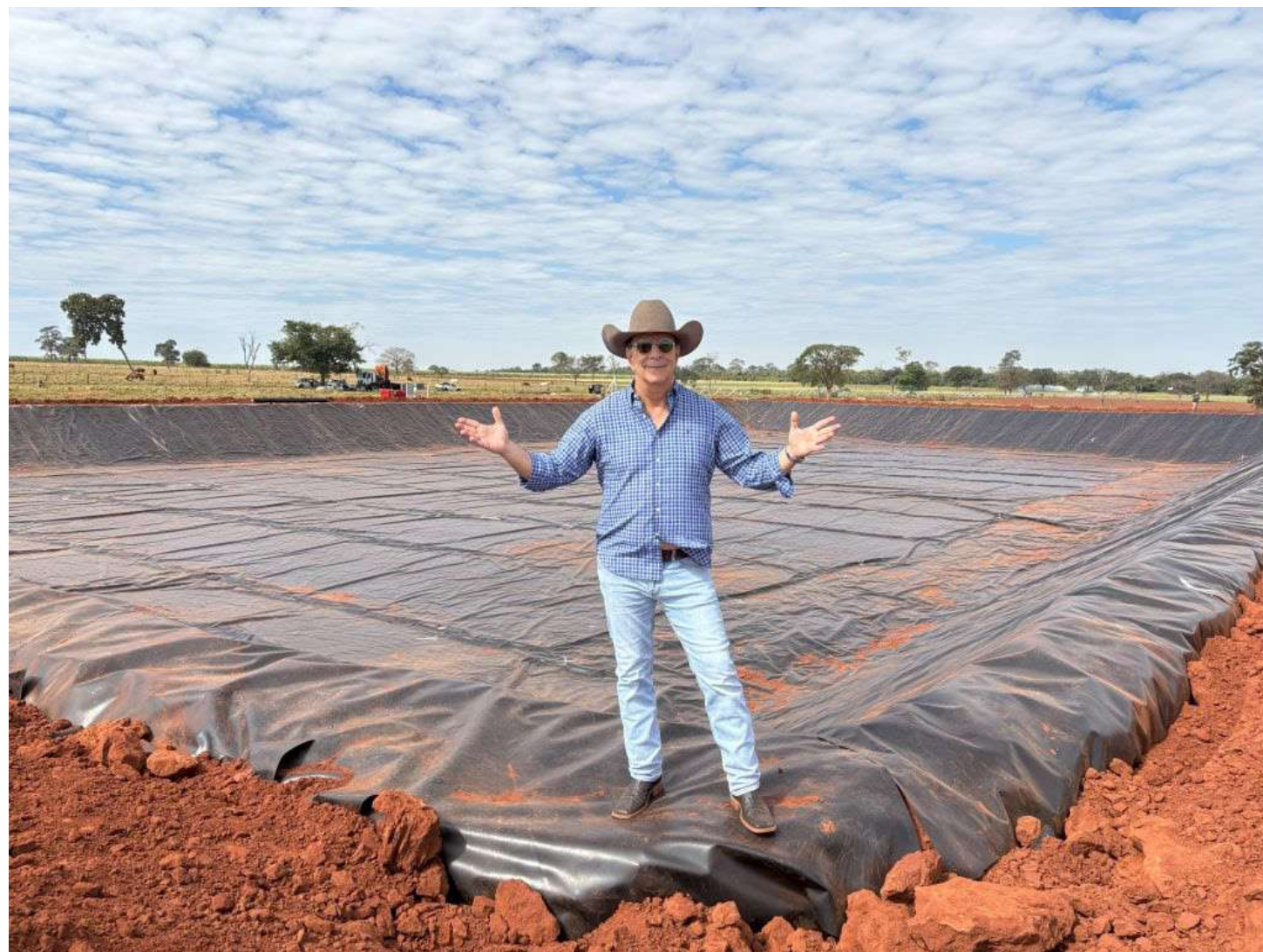
Jamil Buchalla Filho no reservatório em construção em Araçatuba.
